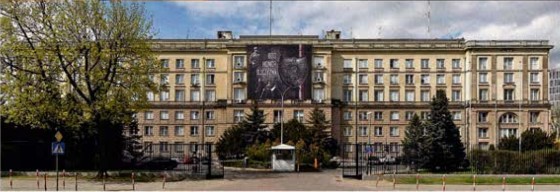
BUDYNEK MSW - SALA KONFERENCYJNA, 1972r.
